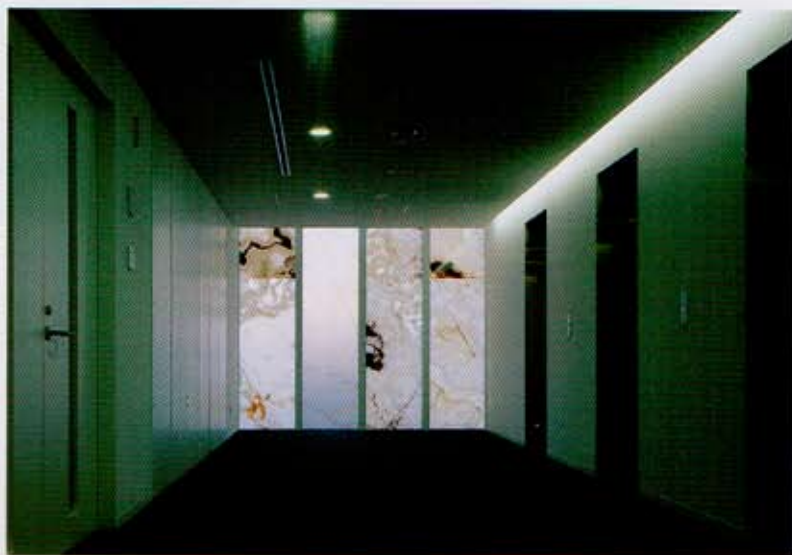
5階エレベーターホール。正面から北側外壁のオニキスを透して外光が入る
